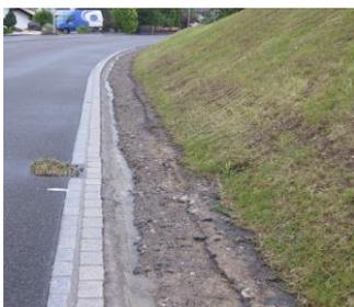
Die Schachtdeckel sind mit Schwemmgut verstopft. Das an der Innenkante der Strasse eingebrachte Kies wird weggeschwemmt.
