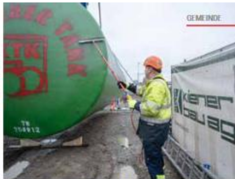
Der 16-Tonnen-Tank wird vorsichtig vom Tieflader gehievt und vor dem Versenken nochmal auf seine Dichtigkeit geprüft.
